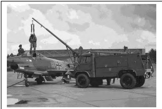
Unimog S 404 Feuerlöschkraftfahrzeug FKfz 750 "Pulver" Aufbau: Sides (Frankreich) Zwei Fahrzeuge dieses Typs waren bei der Bundeswehr in Erprobung. Das gezeigte Fahrzeug mit einem Bergekrane war zur Rettung verunglückter Piloten bei der WTD in Manching eingesetzt.
