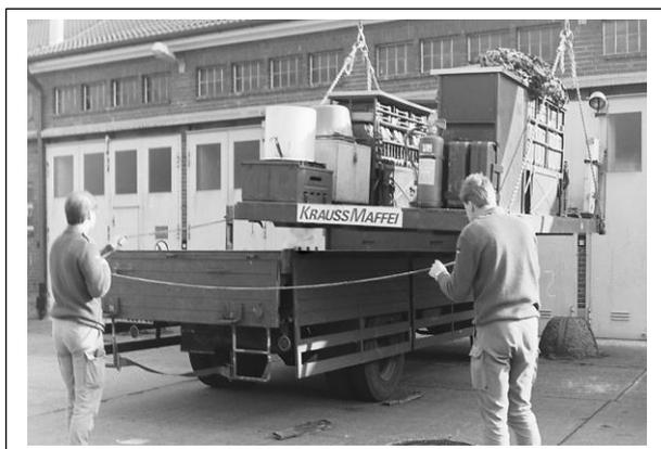
Mercedes-Benz Typ 1017A 5t Pritsche mit Rahmeneinbausatz (Prototyp einer Feldküche der Firma Krauss-Maffei). Der komplette Küchenaufbau konnte vom Fahrzeug abgenommen bzw. abgesetzt werden (siehe rechtes Foto).
