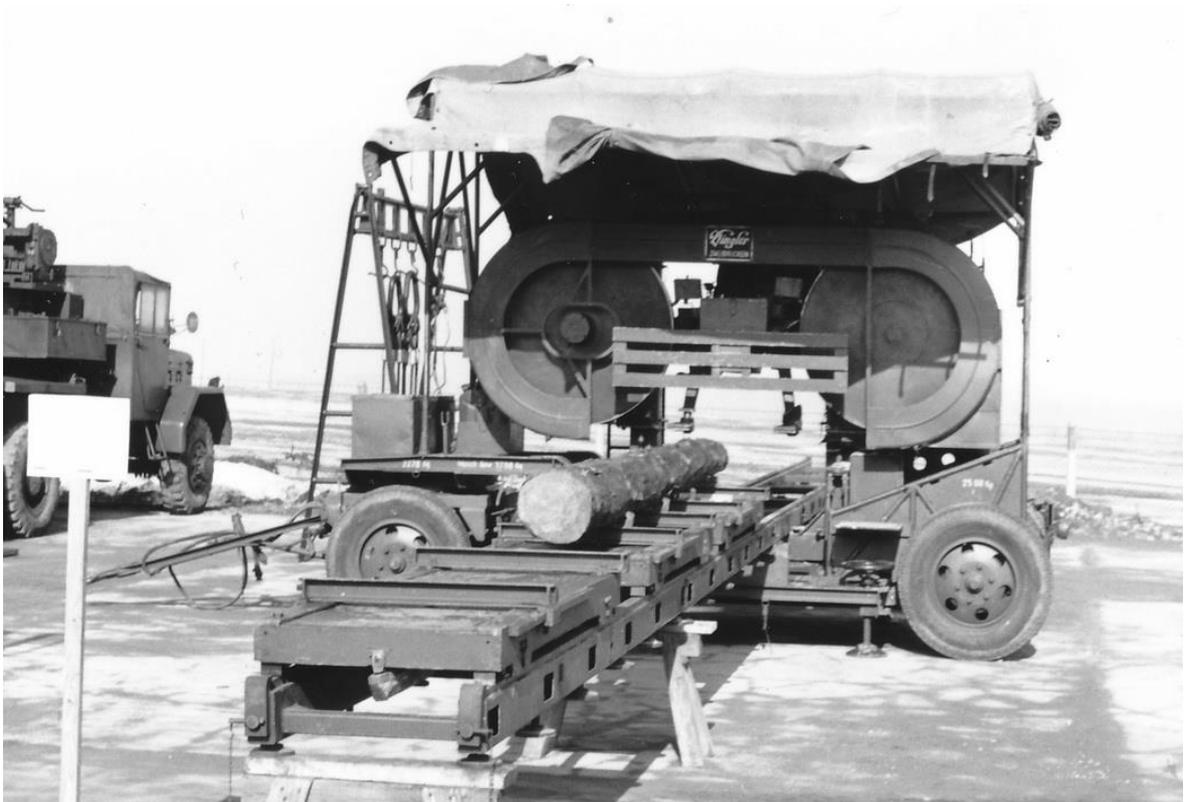
Blockbandsäge auf Anhänger der Firma Dingler. Auf diesem Bild werden Baumstämme zu Eisenbahnschwellen zugeschnitten.
